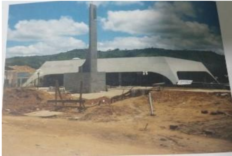
Figura 3- Obra ainda em andamento
